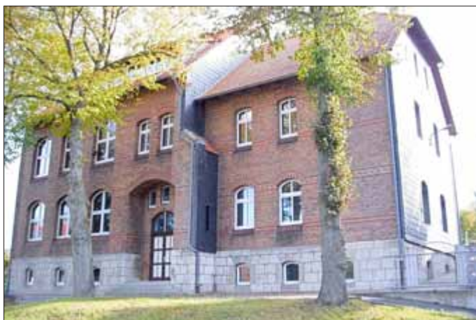
Straßenansicht, Haupteingang ehemaliges Schulgebäude
