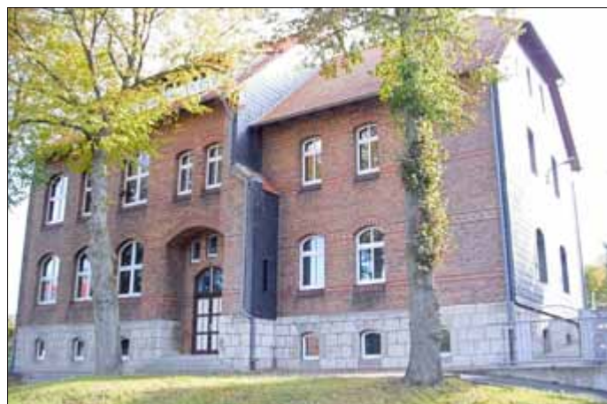
Straßenansicht, Haupteingang ehemaliges Schulgebäude
