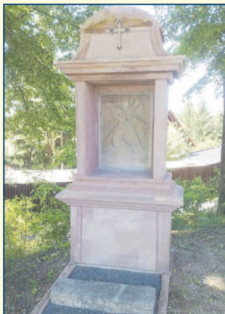
... und nach der Restaurierung
