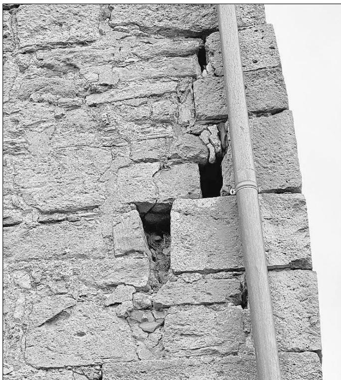
Statisch bedenkliche Verformung der Außenschale des westlichen Turmmauerwerks im Sommer 2021
